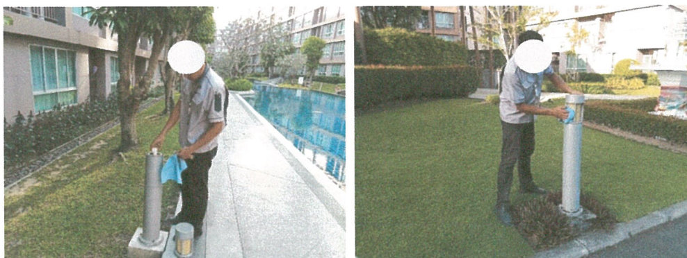
รูปภาพที่ 2.49 การทำความสะอาดหลอดไฟโคมไฟ
