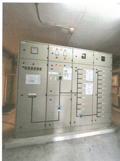
รูปภาพที่ 2.45 Capacitor Bank
