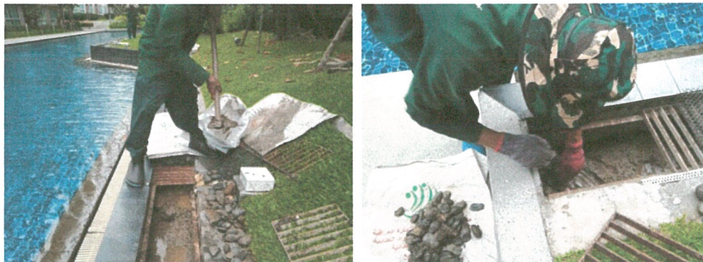
รูปภาพที่ 2.46 การขุดลอกตะกอนรางระบายน้ำ
